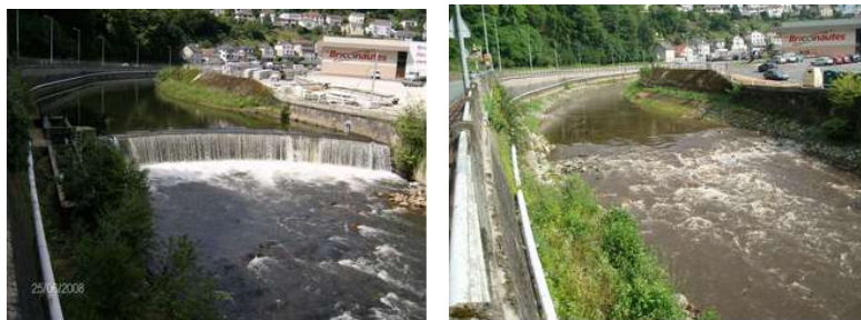
Exemple d'arasement de seuil sur la Corrèze dans l'agglomération de Tulle (Source : retours d'expérience – EauFrance)
