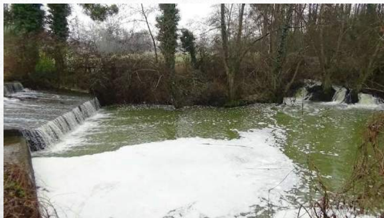
Seuil du moulin de l'Ecuelle (à gauche) et confluence du bras de contournement avec la Chalaronne (à droite)
