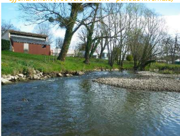
Retenue du seuil au droit du camping avant effondrement (vue vers l'amont - période estivale)
