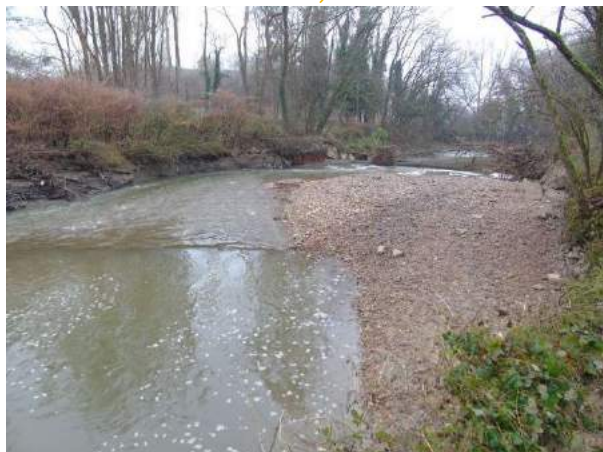
Secteur à l'amont immédiat du seuil après effondrement (vue vers l'aval - décembre 2016)
