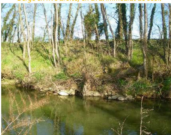
Digue en rive droite à l'aval du seuil
