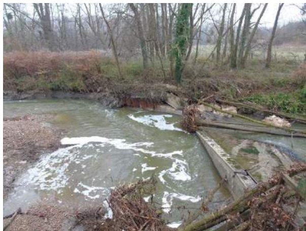
Le seuil après effondrement (vue vers l'aval - décembre 2016)
