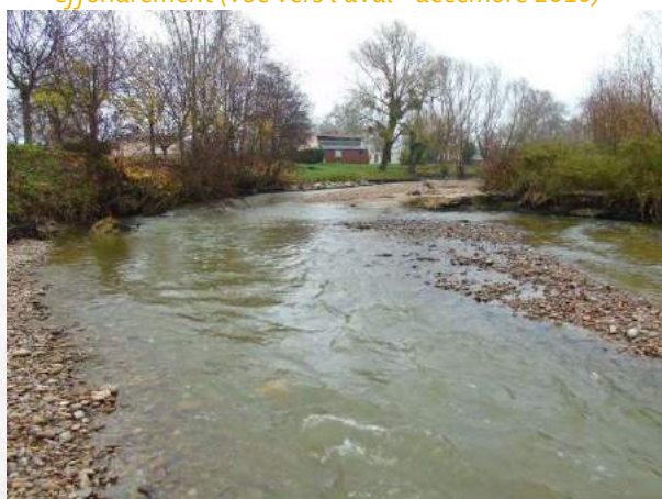
Retenue du seuil au droit du camping après effondrement (vue vers l'amont - décembre 2016)
