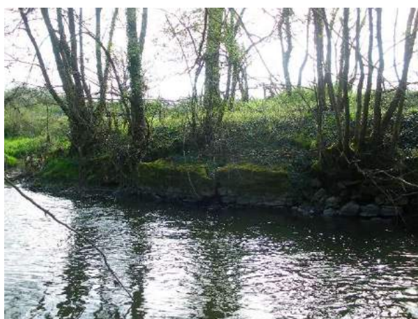
Enrochements en rive gauche en aval du seuil
