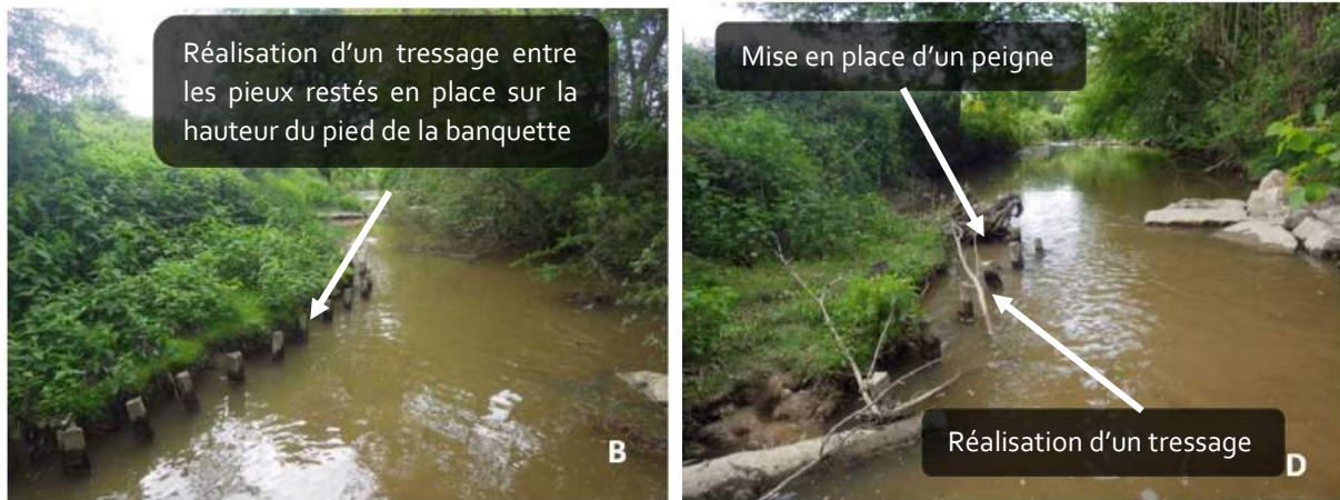
Etat des banquettes sur le site des Oures et proposition d'amélioration
