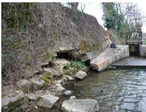
Berge en rive droite, en aval immédiat du seuil
