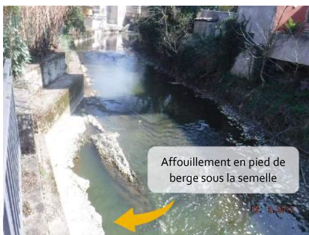
Berge en rive droite de la Chalaronne en aval du pont de la rue Pierre Jeme
