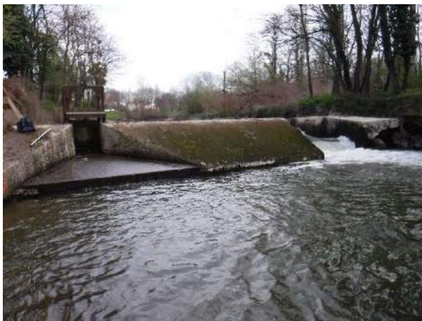
Le seuil avant effondrement (vue vers l'amont - période hivernale)
